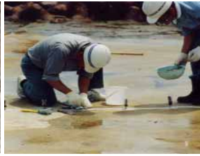
クラック補修状況(注入工)
