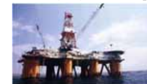
海上大型掘削装置
