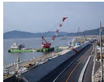
海岸堤防の耐震対策(高知県南国市)
