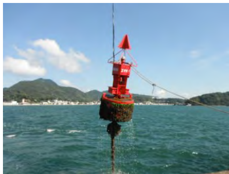
灯浮標の定期交換
