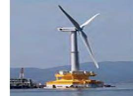
福島沖の5MW浮体式風車「ふくしま浜風」
