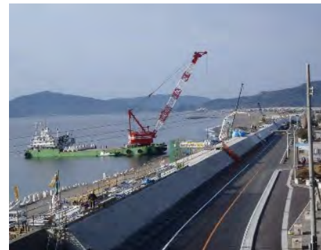
海岸堤防の耐震対策(高知県南国市)
