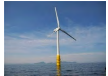
再生可能エネルギーによる発電のイメージ(長崎県五島市)
