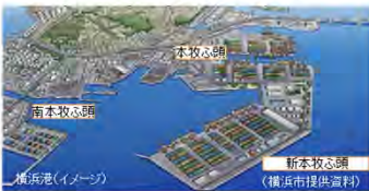
(事例)ハードの整備:横浜港
