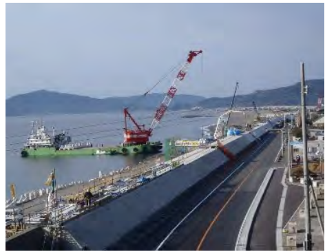
海岸堤防の耐震対策(高知県南国市)
