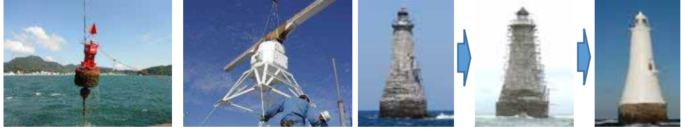
灯浮標の定期交換 空中線回転機構部の定期交換 外壁を補修後、塗装等
