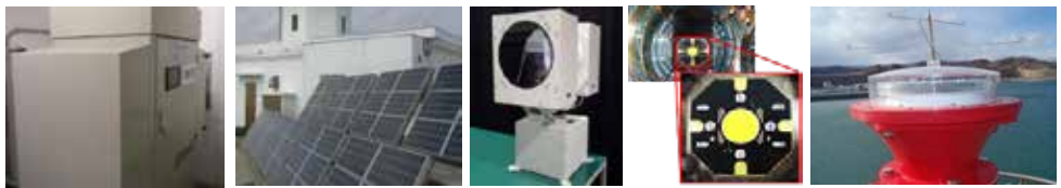
発電機の換装 太陽電池化 高輝度LEDの導入 耐波浪型LED灯器の導入
