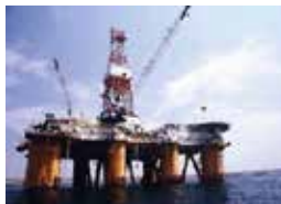
海上大型掘削装置
