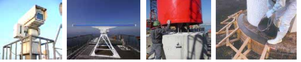
監視カメラの整備 レーダーの整備 基礎新設 亀裂補修(環境遮断)
