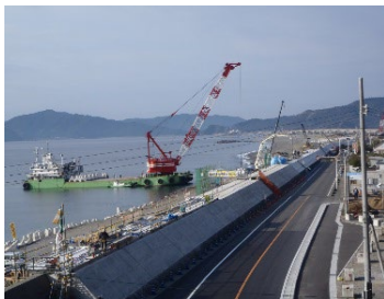
海岸堤防の耐震対策(高知県南国市)
