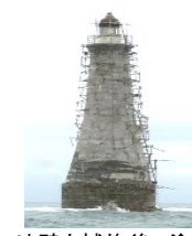
外壁を補修後、塗装等
