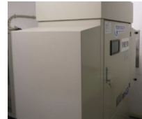
発電機の換装
