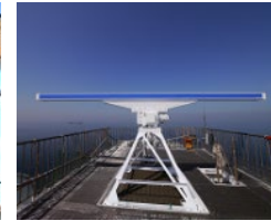
レーダーの整備
