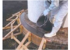
亀裂補修(環境遮断)
