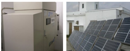
発電機の換装
