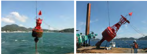
灯浮標の定期交換
