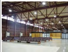
旅客上屋等の改修
