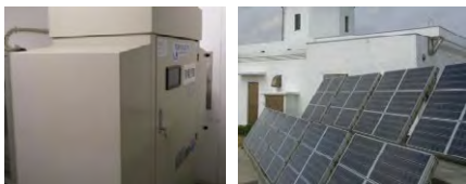
発電機の換装
