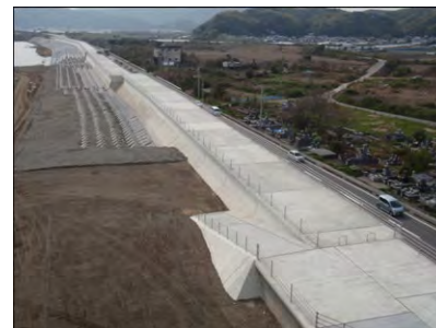
耐震対策が完了した海岸堤防(高知県高知市)
