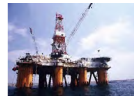
海上大型掘削装置
