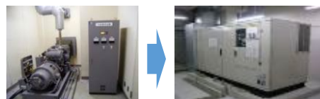
▲非常用電源設備の換装
