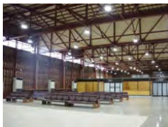
旅客上屋等の改修
