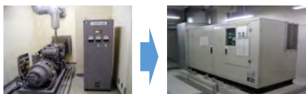
▲非常用電源設備の換装
