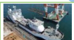
艀装設備(クレーン)
