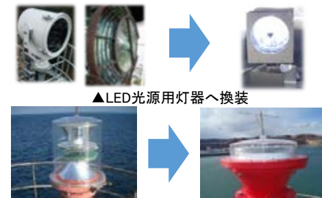
▲耐波浪型LED灯器へ換装
