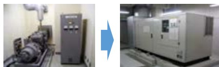
▲非常用電源設備の換装
