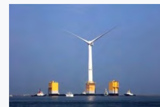
福島沖の実証用洋上風車 (出所:福島洋上風力コンソーシアム)
