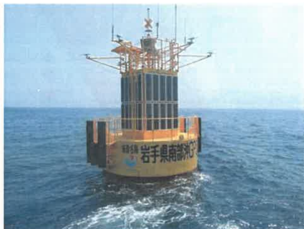
図 2-19 岩手県釜石沖の GPS 波浪計（写真提供：国土交通省東北地方整備局）
