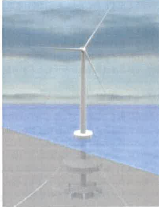
図 2-26 低動揺型洋上風車（スパー型）
