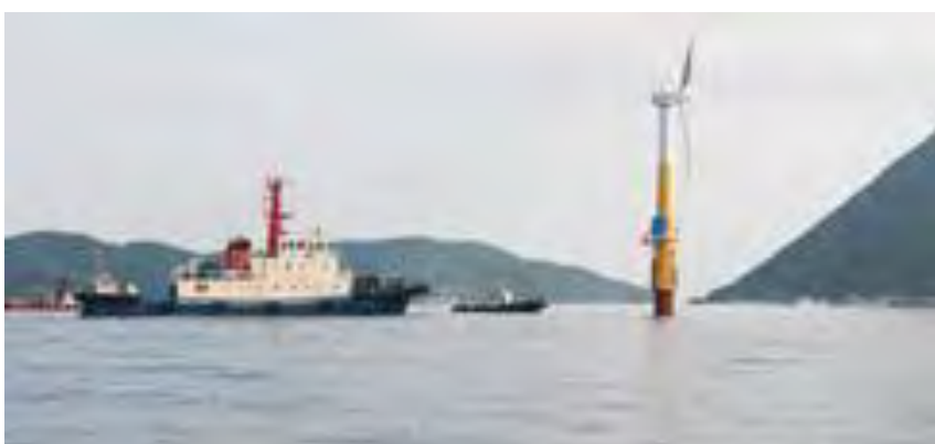
図 2-28 浮体式洋上風力発電設備（長崎県五島市杵島沖）
