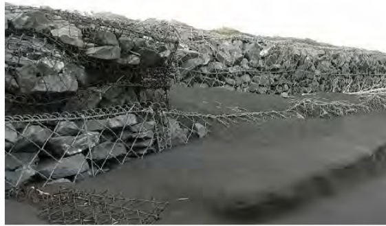
図 4-13 ジャカゴ（蛇籠）、フトンカゴの様子
