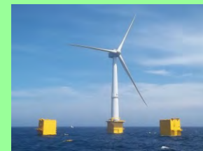
7MW浮体式風車 「ふくしま新風」
