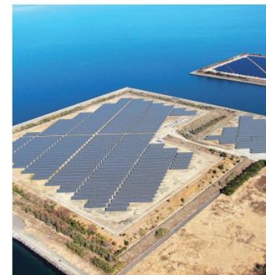
大村メガソーラー第1発電所
