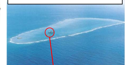
写真2 新素材の開発(沖ノ鳥島における評価試験)
