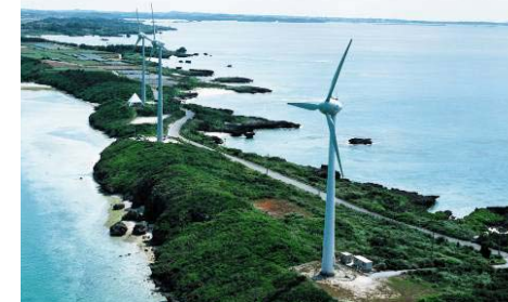
風力発電施設
