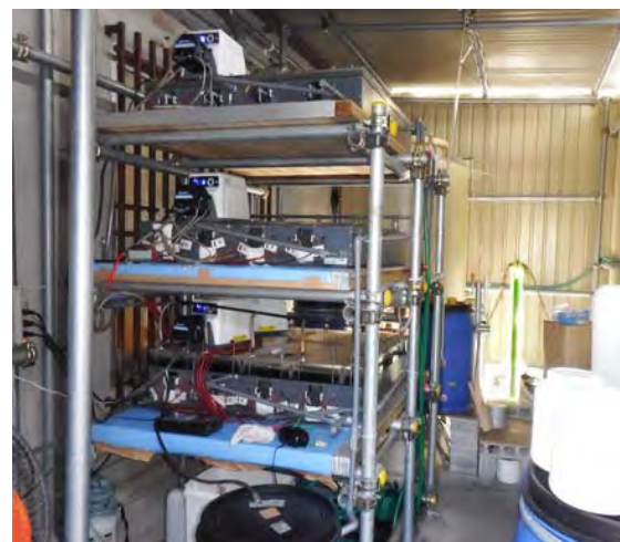
沖縄県内の泡盛醸造所に設置した微生物燃料電池
