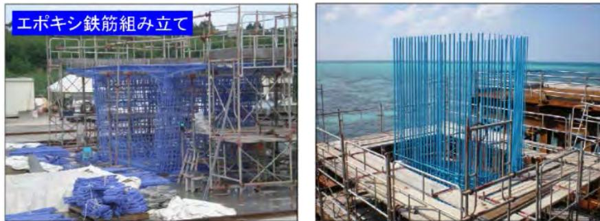
写真 伊良部大橋での塩害対策事例（左側：上部工 右側：下部工）
