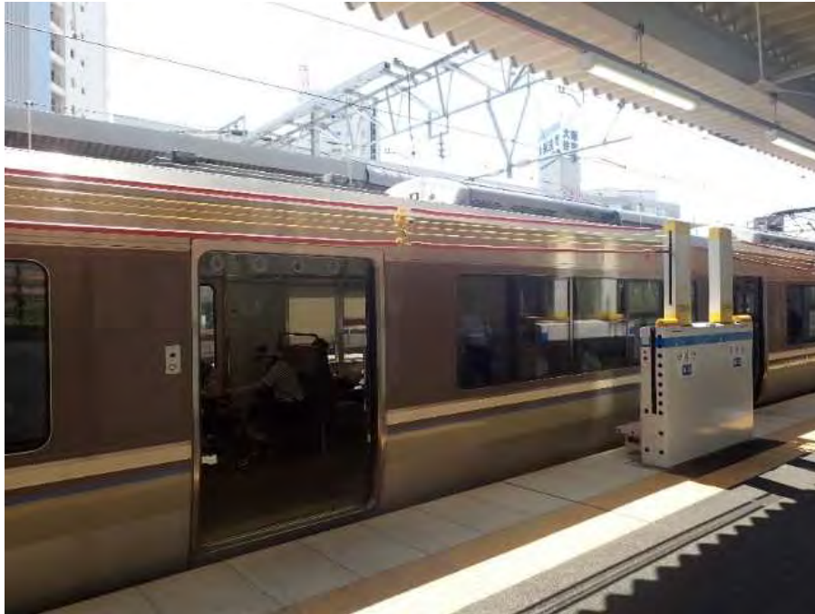
写真 昇降ロープ式ホーム柵 高槻駅（JR西日本）
