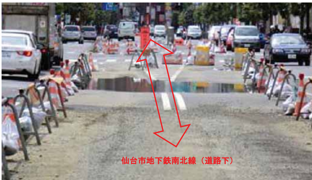
写真 仙台市地下鉄南北線・長町1丁目付近上部の路面沈下の状況
