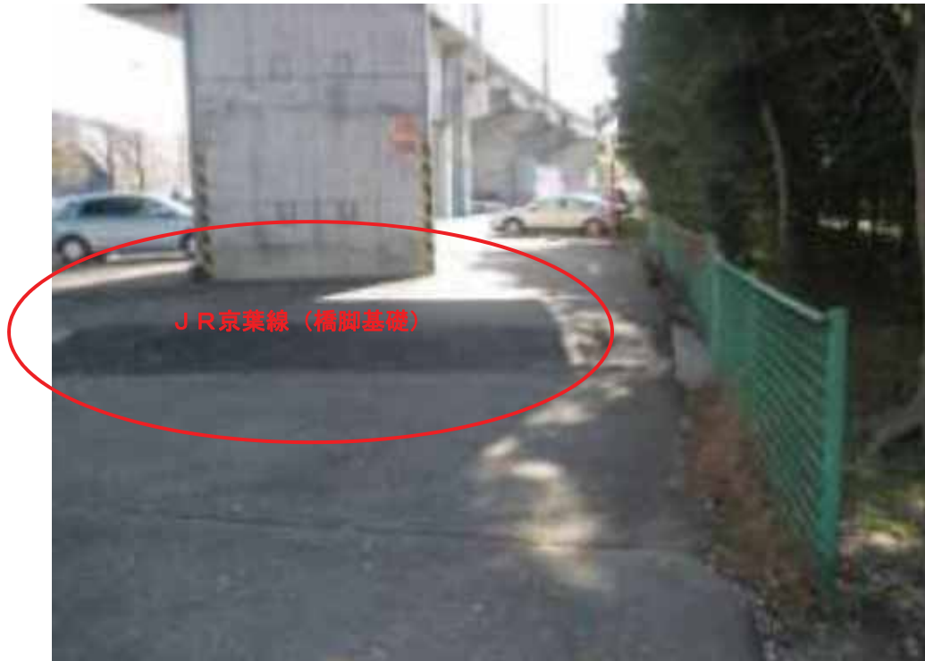
写真 JR京葉線の橋脚の基礎部分（フーチング）約20cm 抜け上がりの状況（千葉県浦安市）
