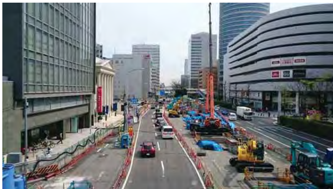
写真 地下鉄工事期間中の車線規制の様子（相鉄東急直通線新横浜駅（仮称）付近）
