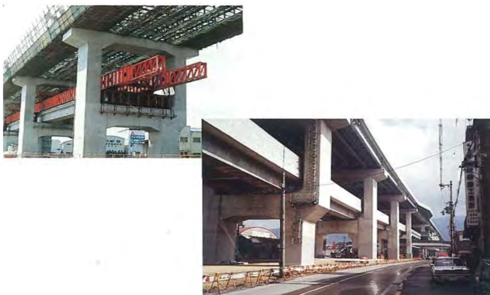
一体高架構造区間
