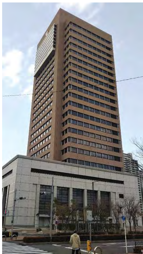
東大阪市役所 本庁舎
