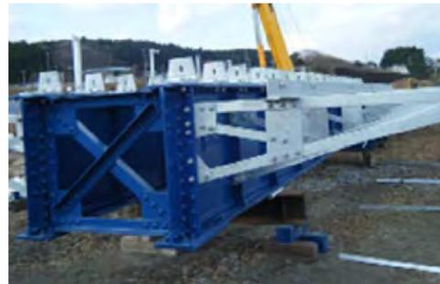
写真 補修後の大浜川橋梁の橋桁
