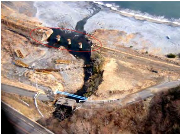
写真 橋桁が流出した大浜川橋梁
