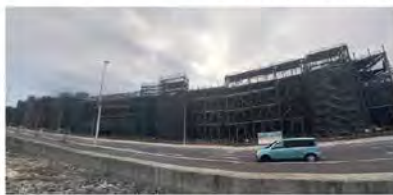
サンエーパルコ建設現場
