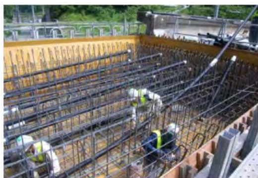
写真 施工状況(シースの設置)
