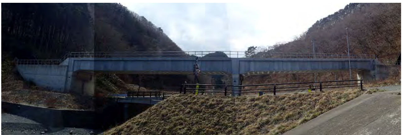
写真 復旧後の旧北リアス線・ハイベ沢橋梁
