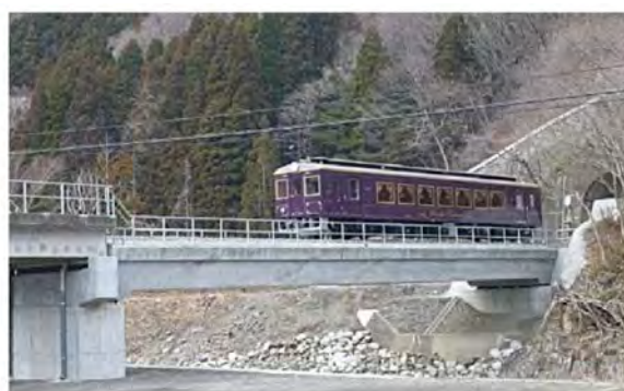
写真 復旧後のPCホロースラブ桁
