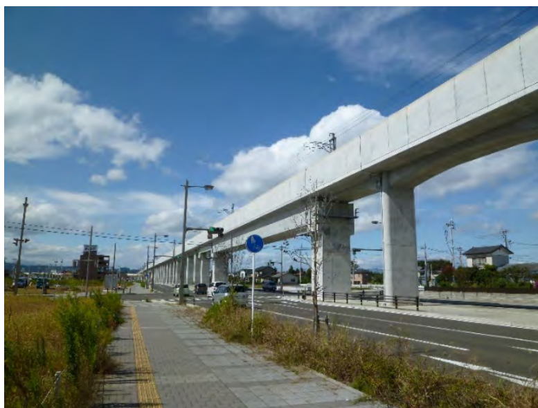
写真 仙台空港鉄道（上下線の道路に挟まれた高架橋）
