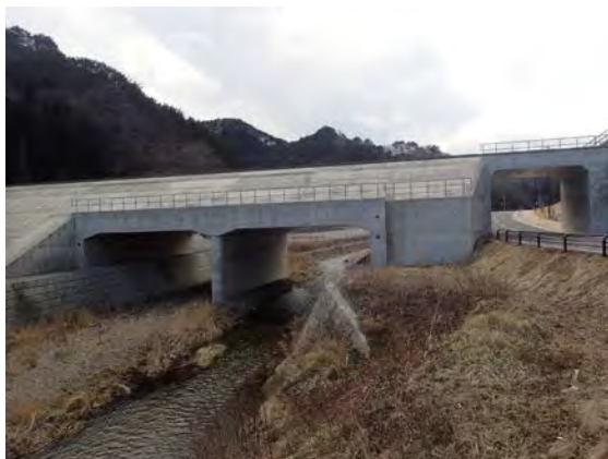
写真 復旧後の旧北リアス線・松前川橋梁
