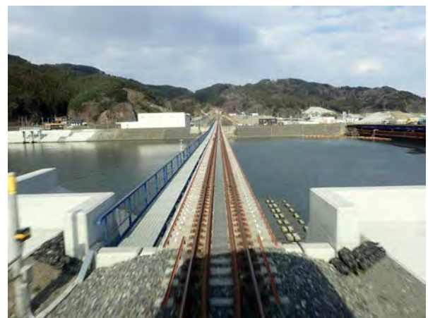
写真 大槌川橋梁
