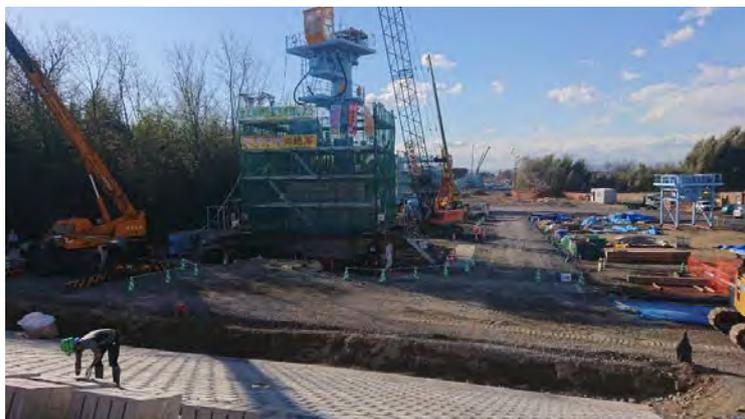
写真 橋脚を施工中の鬼怒川橋梁
