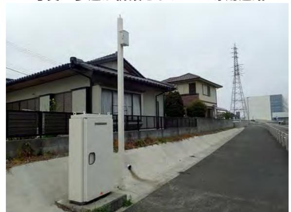
写真 運行管理システム制御盤とアンテナ
