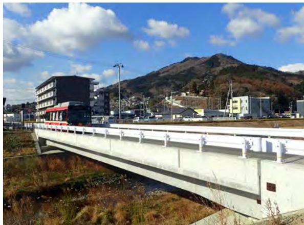
写真 新設された橋梁（鉄道荷重）
