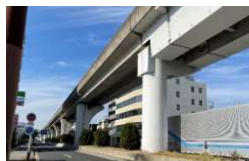
写真 ゆとりーとライン高架橋
