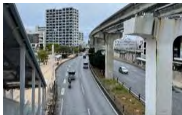
写真 国道330号（おもろまち付近）
