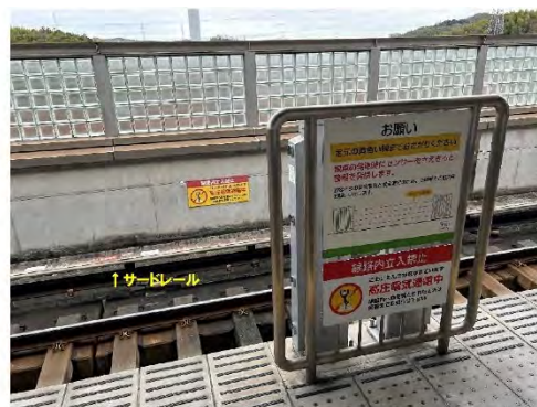
近鉄けいはんな線 電車線路の注意喚起
