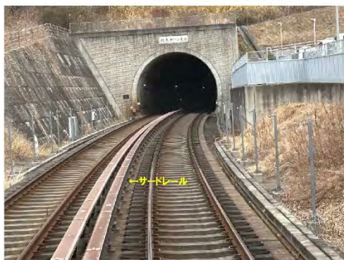
近鉄けいはんな線 山岳トンネル
