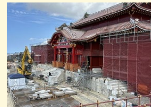
大龍柱 石階段設置中 (R8 2/26)
