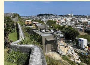
水槽2配管設置中 (R8 2/26)
