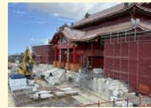
大龍柱 石階段設置中 (R8 2/26)
