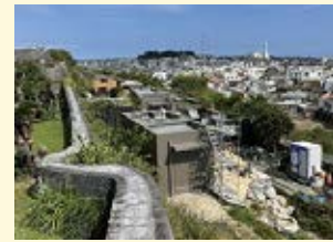
水槽2配管設置中 (R8 2/26)
