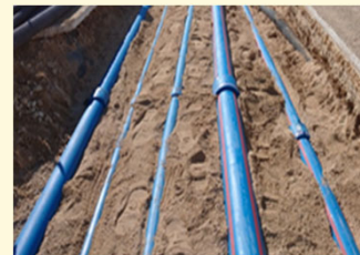
連結送水管等の城郭内における 防災・防火設備の整備
