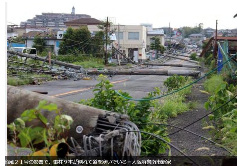
台風21号の影響で、電柱9本が倒れて道を塞いでいる＝大阪府泉南市新家
