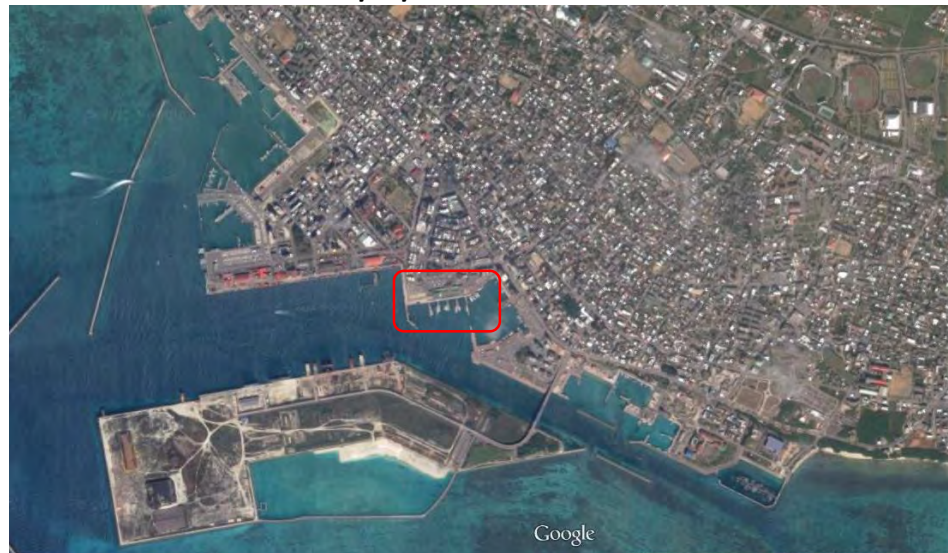
石垣港離島棧橋
