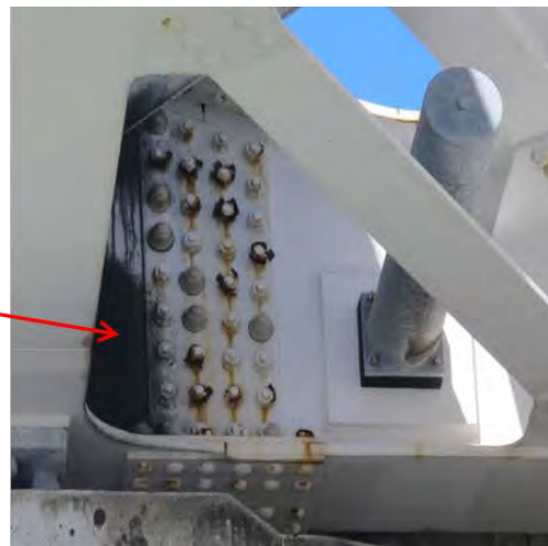
ボルト接合部の腐食(那覇市)
