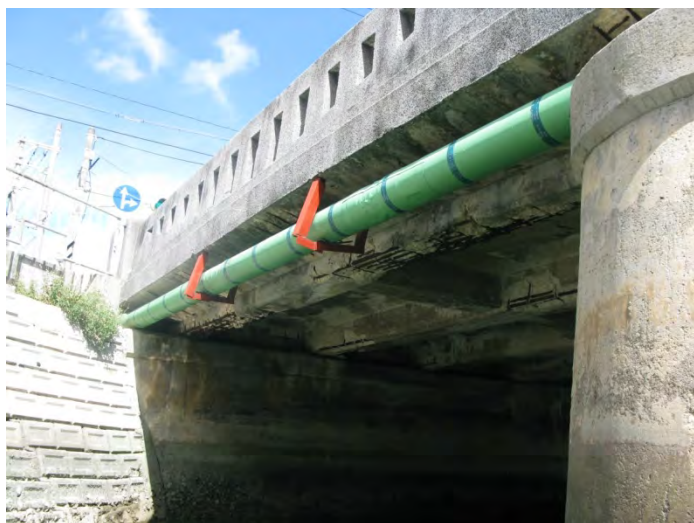
塩害劣化で通行止め⇒撤去したRC桁橋(那覇市)
