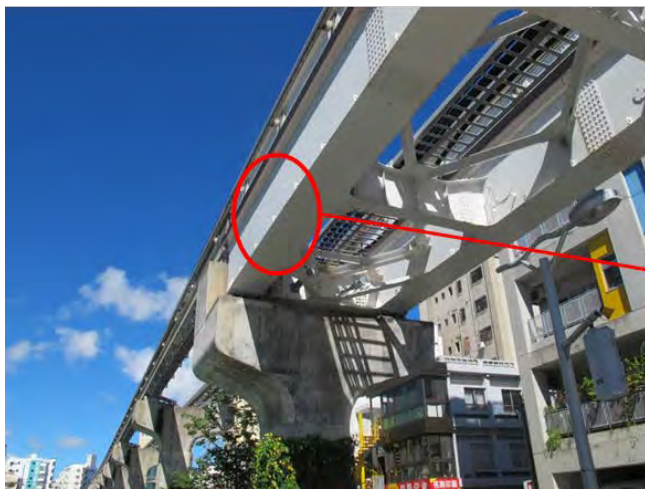
ボルト接合部の腐食(那覇市)
