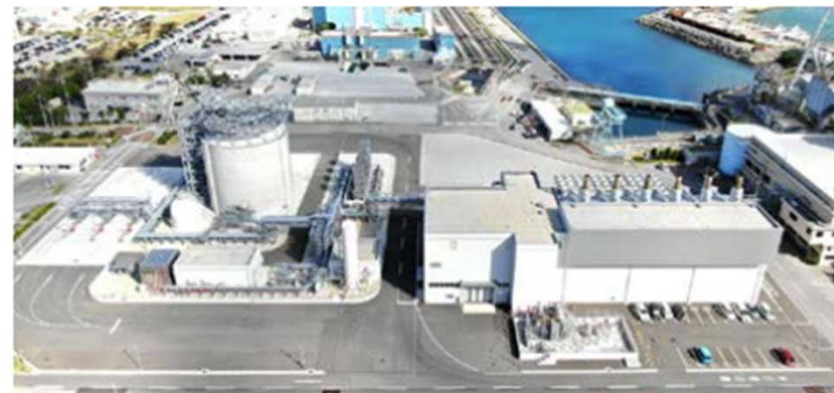
▲牧港ガスエンジン発電所
