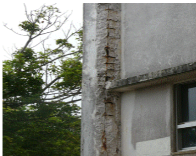
鉄筋が剥き出しになった校舎
