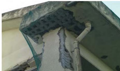
防護ネットを張る校舎
