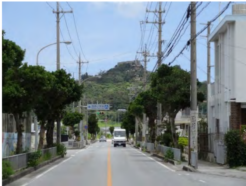
世界遺産(勝連城跡)に向かう道路の景観を阻害する電柱
