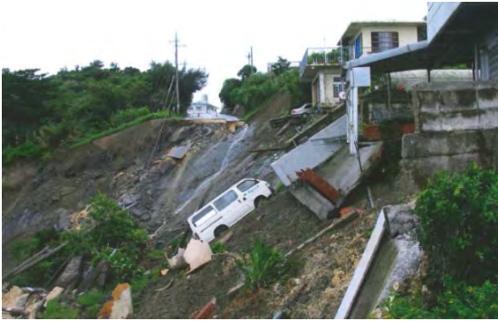
平成18年安里地すべり被害状況(中城村)
