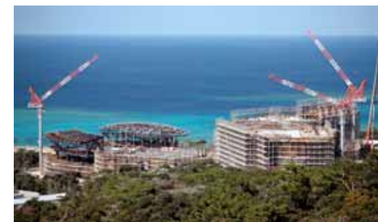
キャンパス建設現場（平成 21 年 1 月現在）
