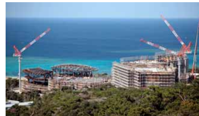
【写真】丘陵側から第1研究棟・管理棟工事現場を望む (2009年1月現在)
