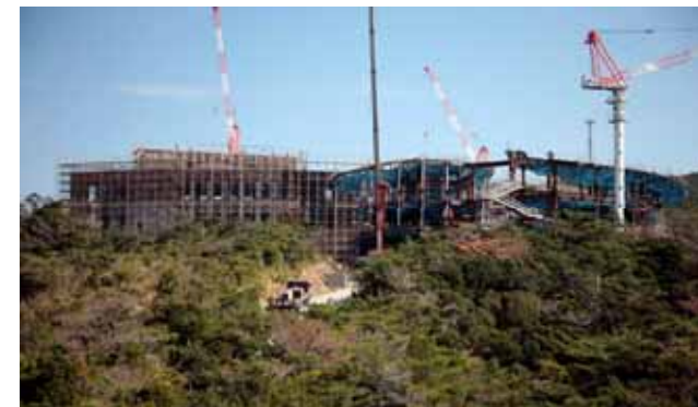
【写真】第1研究棟・管理棟建設地 (2009年1月現在)
