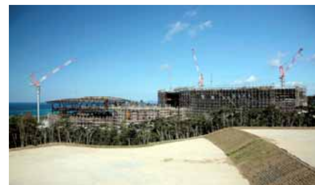
【写真】第2・第3研究棟用地から第1研究棟・管理棟工事現場を望む(2009年1月現在)
