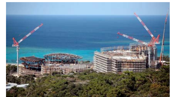
キャンパス建設現場（平成21年1月現在）
